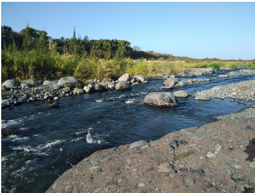
Figure 15 – Enrochements (centre de la photo) disposés sur le cours principal de la rivière pour dériver les eaux entre les canaux de l'APBRSE et Nout Passion.
